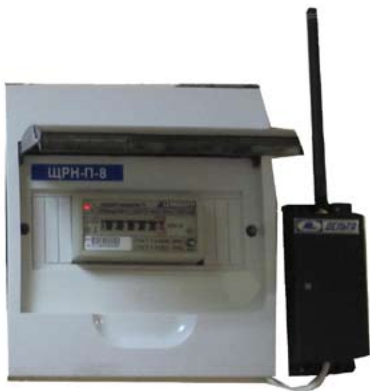
Электросчетчик подключен к передатчику
